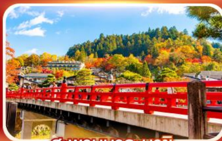
สะพานนากะบาชิ
